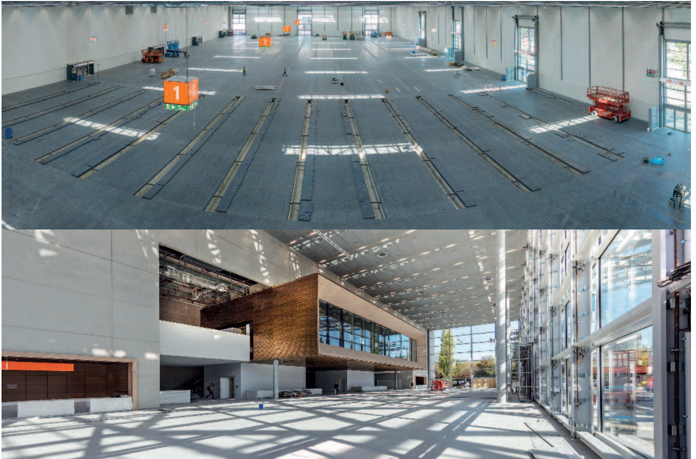
Nach der Verschiebung von Messen bleibt die neue Halle 1 auf dem Düsseldorfer Messegelände vorerst leer.
